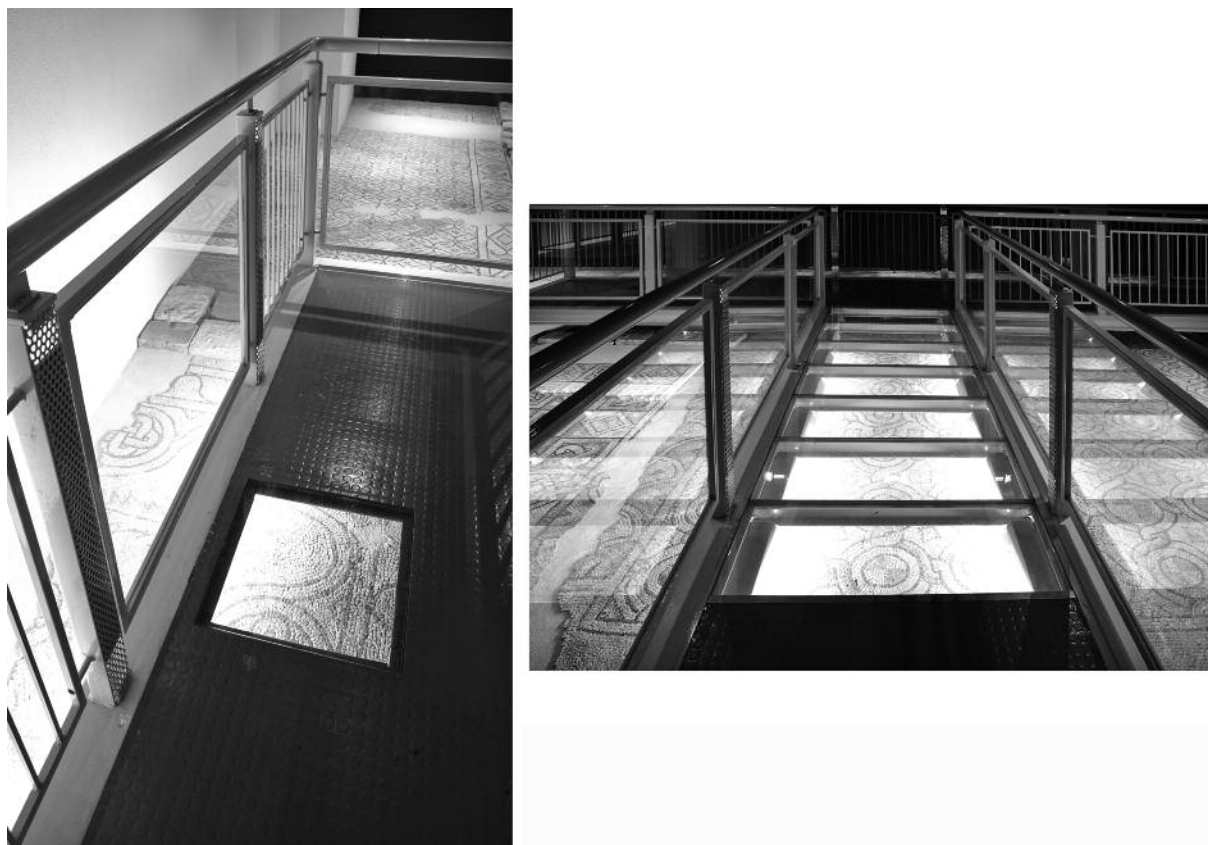
Fig. 10. Ravenna, Domus dei Tappeti di Pietra , particolari della passerella con riquadri pavimentali in cristallo delle stanze 3 e 6 (tav. di progetto 5).
